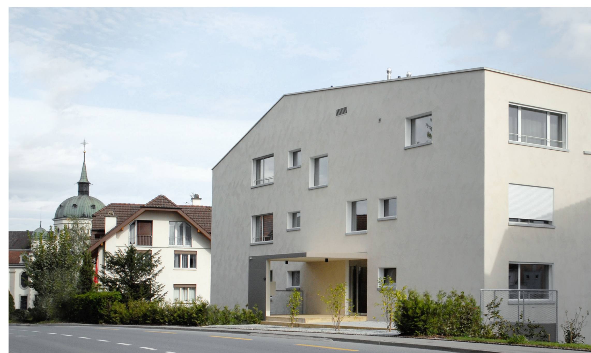
Ansicht MFH Rothenburgstrasse, GKS Architekten+Partner AG
