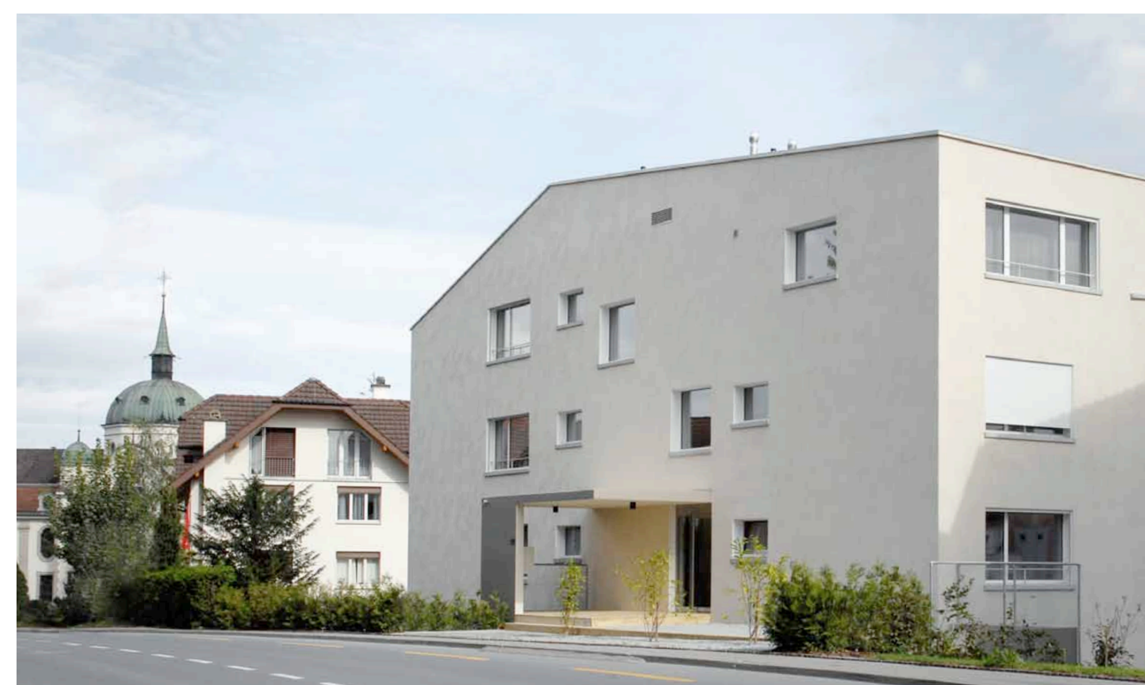
Ansicht MFH Rothenburgstrasse, GKS Architekten+Partner AG
